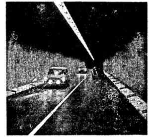
Der lawinsichere Fibertauern-Tunnel hat leicht gewölbte Seitenwände und wird von 3200 Neonröhren taghell erleuchtet
