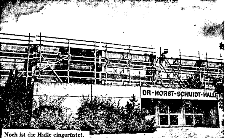
Noch ist die Halle eingerüstet.
