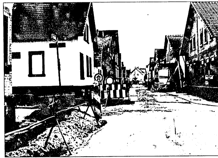
Aufgerissen: Auf etwa 130 Meter Länge wurde unlängst die Rheinstraße zwischen Wog- und Rethausstraße aufgerissen. Grund: Neben Elektro-Kabeln für die Haushalte und die Straßenbeleuchtung verlegt die Telekom ihre Breitbandkabel in den Untergrund. Zudem wird nach Angaben der Gemeinde auf der gesamten Länge des Straßenschnitts sowohl der Bürgersteig als auch die Fahrbahn erneuert. Die Baueinheiten werden voraussichtlich erst Ende Juni beendet sein. Foto: Maahn
