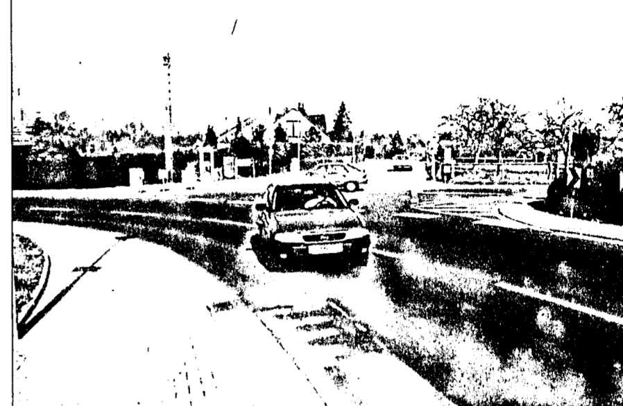
Soll demnächst baulich verändert werden: Die Kreuzung Neurothweg/Albert-Schweitzer-Straße/Hainer Weg. Dafür plädierte der Ortsbeirat in seiner jüngsten Sitzung. Foto: Wiegand
