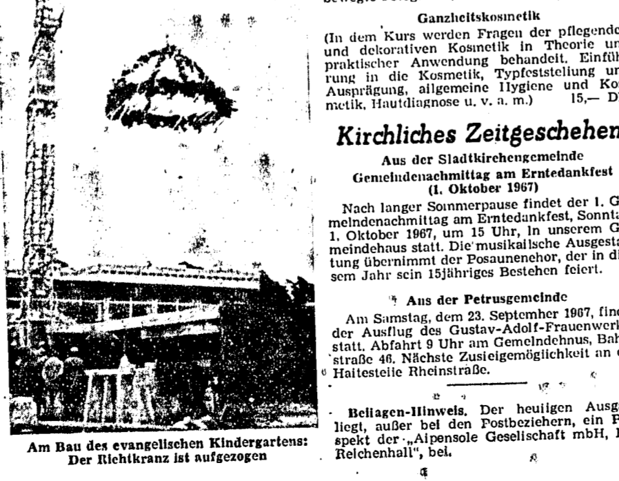
Am Bau des evangelischen Kindergartens: Der Richtkranz ist aufgezogen
