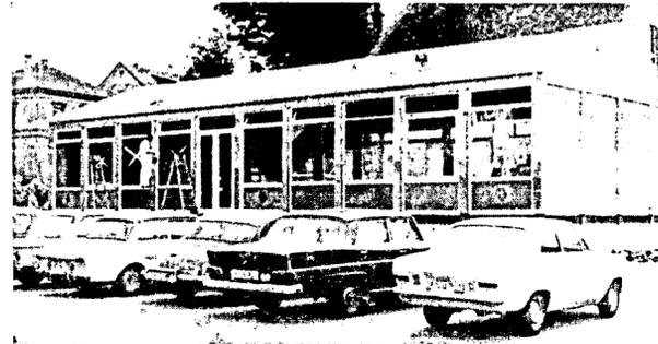
In wenigen Tagen wuchs auf dem Rathaushof der Pavillonbau für die Stadtverwaltung empor. In Fertigbauweise errichteten die Facharbeiter das Gebäude aus Einzelteilen. Vom Fundament angefangen bis zum Dachgebälk wurden die Holzgänge aufgerichtet. Das Verwaltungsgelände wird nun bis zum Einzug des Magistrats in ein neues Rathaus mehreren Ämtern — wie dem Standesamt — dienen. Unsere LZ-Bilder zeigen, wie es begann und wie das Gebäude nun aussieht.
