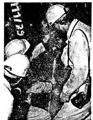
Werksleiter, Markschneider und Vertreter des Bergamts bei der Mächtigkeitmessung eines aufgefundenen Flözes. Schwören muß heute keiner mehr, aber nach wie vor unterliegt strenger Überwachung, was in der Tiefe der Erde geschieht.
