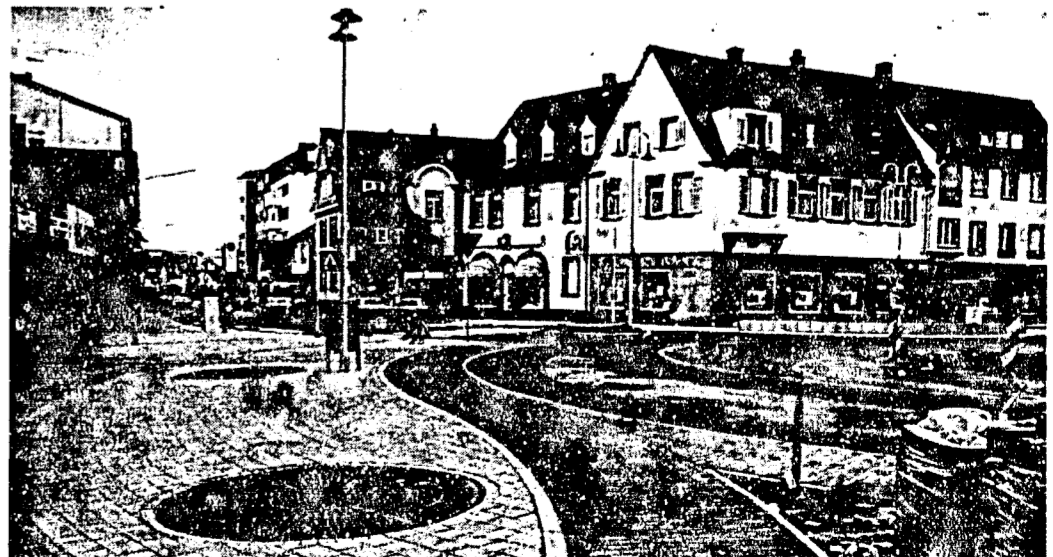
Der neue Lutherplatz nimmt langsam Gestalt an. An die Verkehrsführung kann man sich langsam gewöhnen, doch bis zu seiner endgültigen Fertigstellung werden noch manche Accessoires wie Brunnen, Uhrtürmchen, Pflanz- und Ruhebänke hinzukommen. Foto: rf
