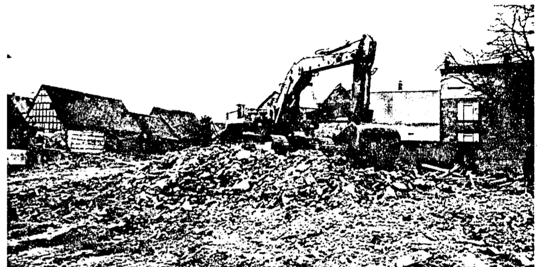
Ganze Arbeit haben die Abbruchmaschinen an der Ecke Dieburger Straße und Fahrgasse geleistet. Das landwirtschaftliche Anwesen ist verschwunden. Hier und auf dem seitherigen Parkplatz soll ein großes Wohn- und Bürohaus entstehen. Foto: rf
