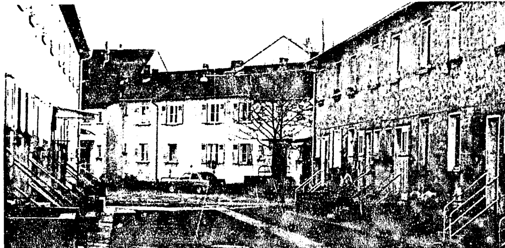
Die „Einfachwohnanlage“ Leukertsweg/Ecke Sehretstraße steht vor dem Abriß. Ab Juli sollen dort Eigentums- und Sozialwohnungen gebaut werden. Foto: cho
