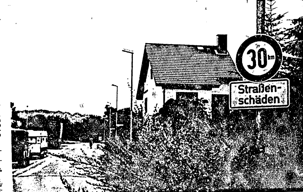
Der fehlende Straßenbelag soll hier wohl durch das Schild „Straßenschäden“ ersetzt werden. Verhängung wäre doch wohl gewesen, diese relativ neue Straße gleich richtig zu vollenden.
