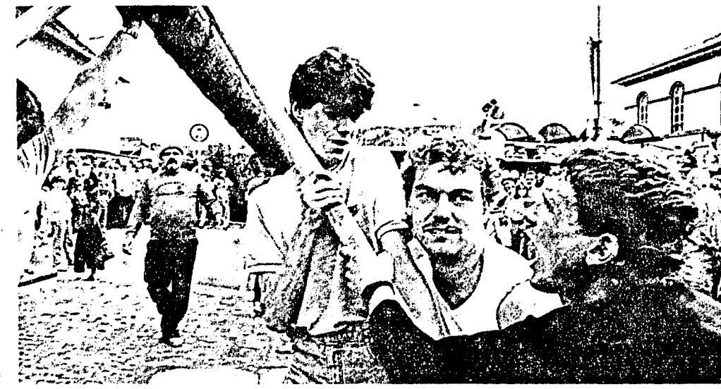
Auch diese drei können sich diesmal einer anderen Aufgabe widmen. Vielleicht graben sie die Pflanzlöcher für die „Kerbbäumchen“. Foto: rt
