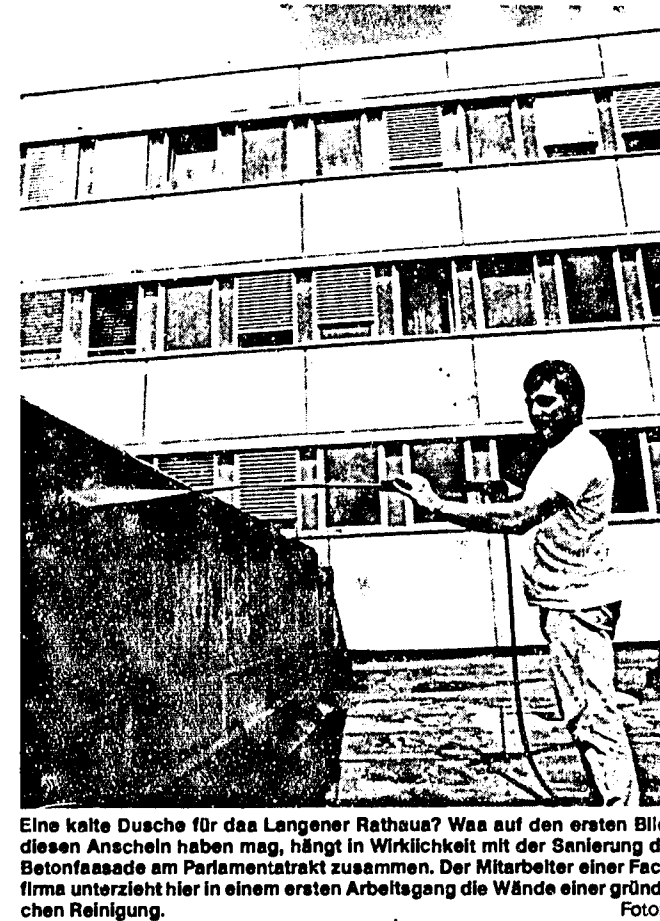
Eine kalte Dusche für das Langener Rathaus? Was auf dem ersten Blick diesen Ansehen haben mag, hängt in Wirklichkeit mit der Sanierung der Betonfassade am Parlamentstrakt zusammen. Der Mitarbeiter einer Fachfirma unterzieht hier in einem ersten Arbeitsgang die Wände einer gründlichen Reinigung. Foto: p
