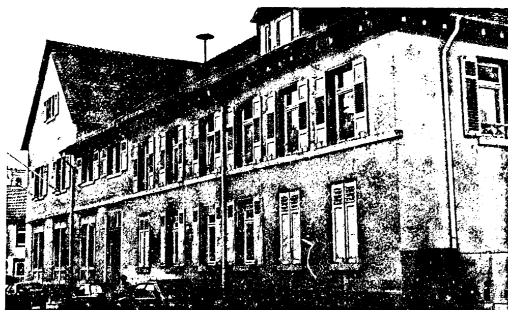
Die Renovierungsarbeiten am Alten Amtsgericht werden rund 860 000 Mark verschlingen. Foto:ast
