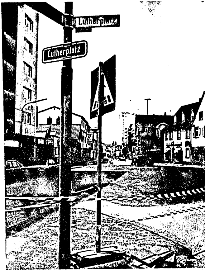
Die Bauarbeiten am Lutherplatz werden in den nächsten Tagen unterbrochen. Während des Ebbezeitraumes wird dort ein provisorischer Kreisverkehr wie vorher eingerichtet, um die durch das Fest bedingten Umleitungen vornehmen zu können. Die Decke der Bahnstraße ist fertiggestellt. Foto: rt
