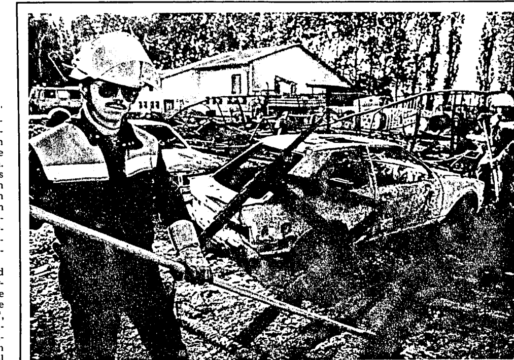
Am Morgen danach: der stellvertretende Ortsbrandmeister Ulrich Schumann bei Nachlöscharbeiten. Reithalle und Stall sind völlig abgebrannt. Auch Autos wurden ein Raub der Flammen. Foto: sor
