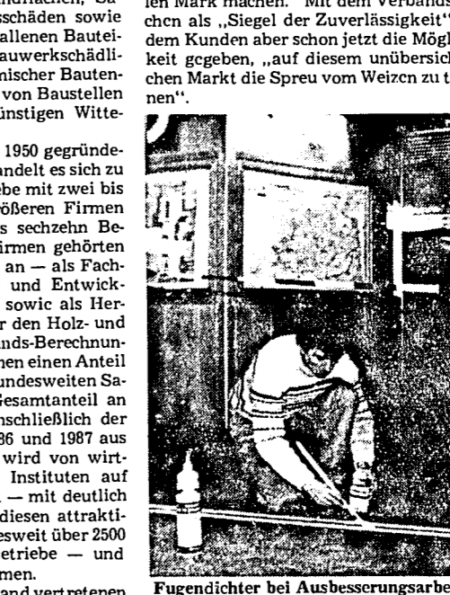
Fugendichter bei Ausbesserungsarbeiten.
