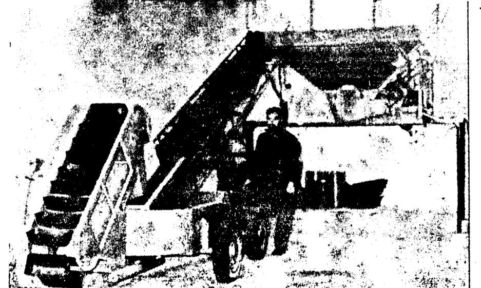
Für den Winterdienst gut gerüstet stehen besondere Einrichtungen, wie dieser moderne Streuer, bereit.
