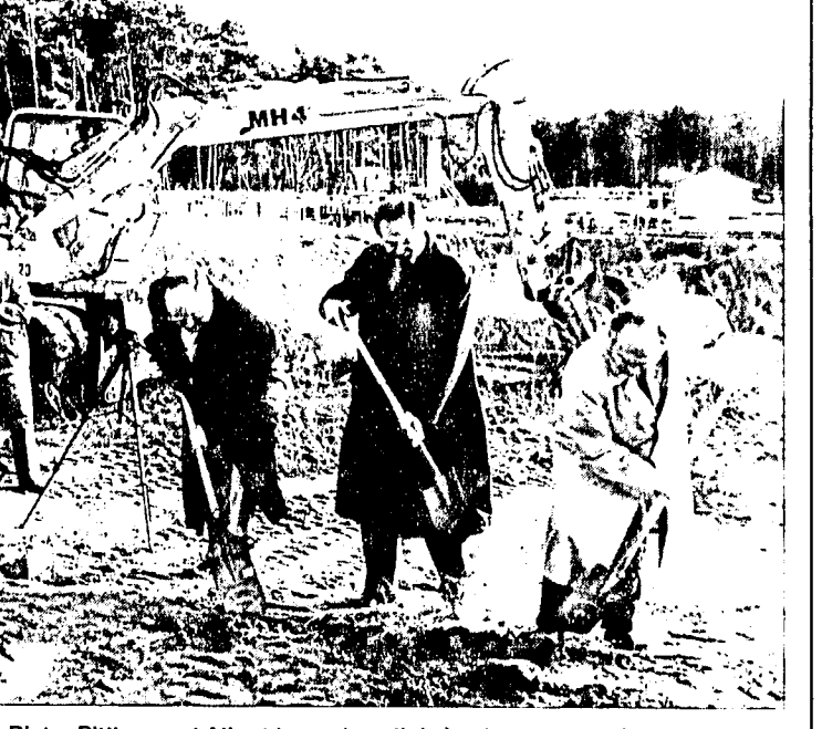
Die Bürgermeister Heinz Eysen, Dieter Pitthan und Albert Leyer (von links) nahmen am Freitag den ersten Spatenstich zur Erweiterung und Modernisierung der Kläranlage des Abwasserverbandes Langen/Egelsbach/Erzhausen vor. aus, daß die neue Abwasserreinigung Mitte 1997 in Betrieb genommen werden kann“, sagte Pitthan zuversichtlich. Mit der Modernisierung der Anlage kommt der Verband über die gesetzlichen Bestimmungen nach. Die Investitionen werden allerdings auch Gebührenentlastungen nach sich. „Wir erreichen aber eine Abwasser- und Regenwasserbehandlung, von der auch kommende Generationen profitieren werden“, erläuterte Pitthan.
