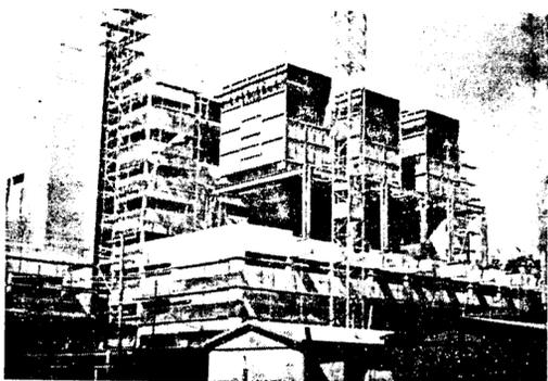
Im Rohbau fertig Zwischen Autobahn, Landstraße und Wald liegt die zentrale Müllverbrennungsanlage des Landkreises Offenbach in der Gemarkung Wildhof. Die Stahlkonstruktionen im ersten Stock werden die Kessel aufnehmen, von denen im Endausbau vier vorgesehen sind.
