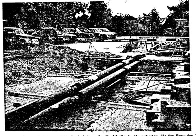
In vollem Gange sind derzeit beim Parkplatz an der Stadthalle die Bauarbeiten, die den Baus des Blockheizkraftwerkes an der Westseite des Hallenbades einleiten. Mittels Durchbohrung sollen unter der südlichen Ringstraße Rohrleitungen durchgeführt werden. Sobald die Leitungen an das bereits bestehende Rohrleitungsnetz zwischen Rathaus und Bezirkssparkasse angeschlossen sind, kann das Gebäude in Angriff genommen werden.
