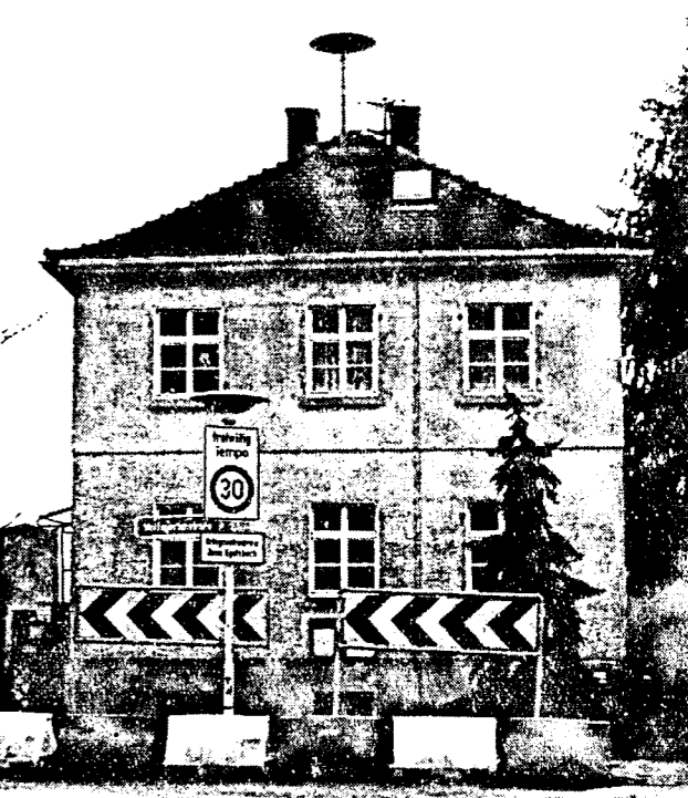
Seit Anfang Juli wohnen zwei pakistanische Familien im ehemaligen Forsthaus. Innen wurde das Gebäude vollständig renoviert. Foto: cho
