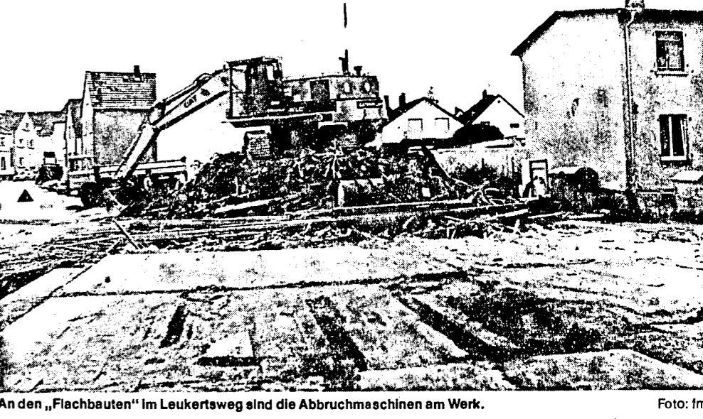
An den „Flachbauten“ im Leukertsweg sind die Abbruchmaschinen am Werk.
