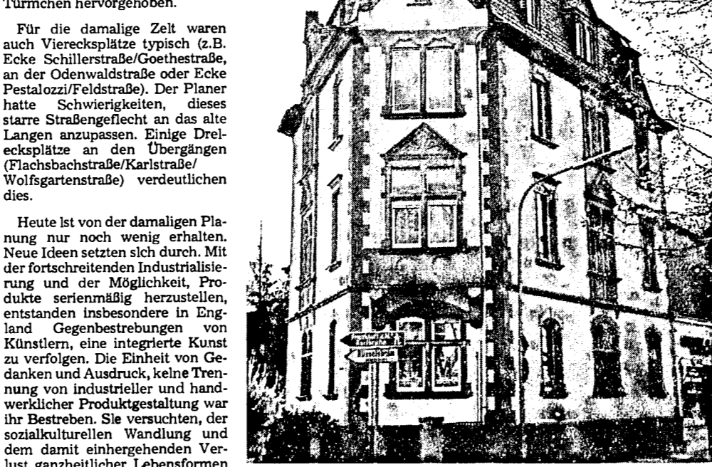
Das sogenannte „Bügelhaus“ in der Bohnestraße ist ein typisches Beispiel aus der Gründerzeit für eine Eckbebauung.
