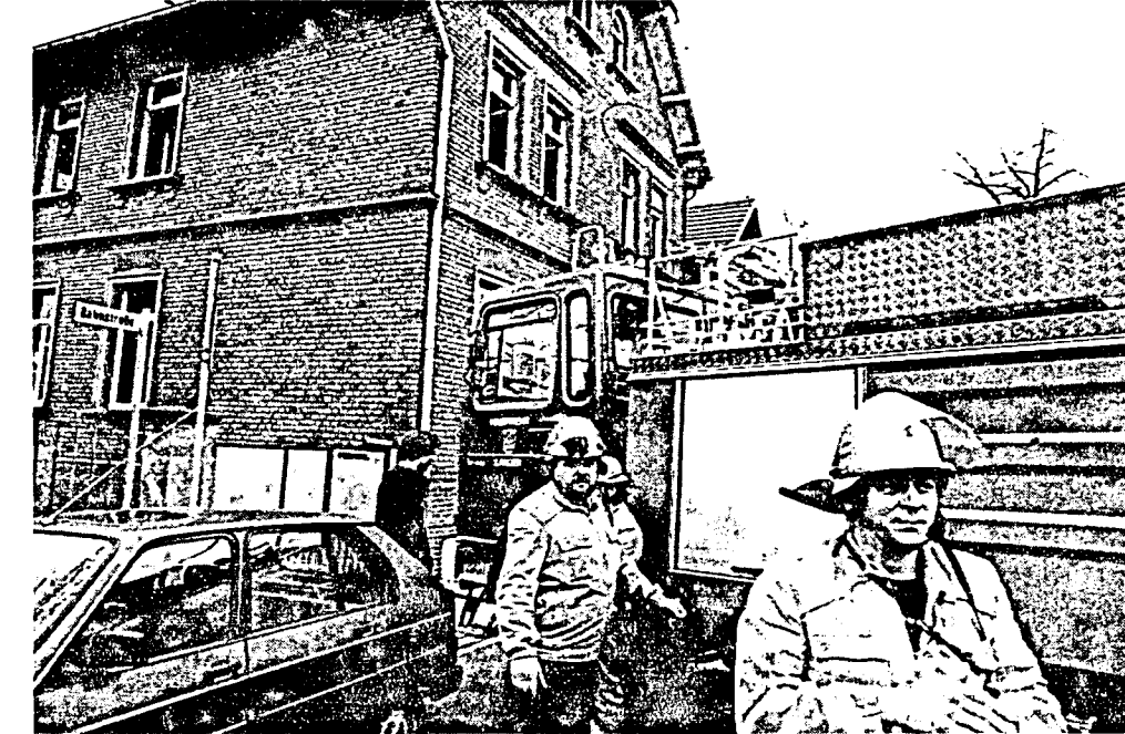
Bei Schweißarbeiten an einer Gasleitung in einem Haus an der Bahnstraße erlitt am vergangenen Dienstag ein Arbeiter leichte Verletzungen. Weil Explosionsgefahr bestand, wurde die Feuerwehr gerufen. Wie es hieß, sei eine mit Umbauarbeiten in dem Haus beauftragte Firma nach Rücksprache mit den Stadtwerken davon ausgegangen, daß sich in der Leitung kein Gas mehr befindet. „Offensichtlich war das aber nicht der Fall“, meinte ein Sprecher der Feuerwehr. In der Leitung sei wohl noch ein Rest des explosiven Stoffes gewesen. Beim Schweißen gab's dann eine Stichflamme. Eine Schutzbrille bewahrte den Arbeiter vor Verletzungen an den Augen. Foto: Sor
