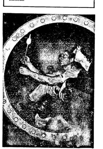
Im Inneren des Antennenmastes waren zwei Monteur mit dem Anziehen der Schrauben beschäftigt, als unser Fotograf sie aufsuchte. Bei einigen dieser Versuche wurde beim ersten Versuch das Gewinde abgeschert. Beim zweiten Anlauf klappte es dann (siehe Bericht auf Seite 3).
