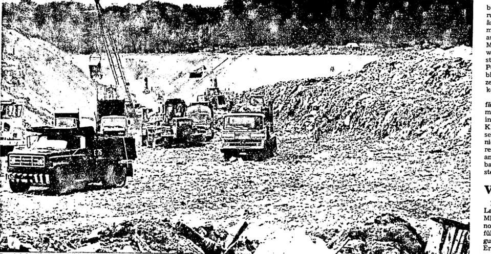
Spezialplastikplanen bilden die Wände eines mächtigen Tales, das in den kommenden drei Jahren mit Müll gefüllt sein wird. Die Grundwasserströme oberhalb einer 15 Meter dicken Tonschicht liegen, werden künftig um die Deponie herumfließen in Richtung Langener Waldsee. Sie werden durch den Müll nicht beeinträchtigt.
