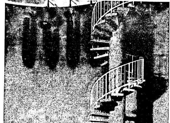
So sieht es im Innern des neuen Wasserbehälters im Mühlal aus. Vorn links der Abfluß des Trinkwassers ins Netz. Eine Wendeltreppe führt zur Sohle des Speichers. Oben links die Zufüsse, das Schwimmventil und der Sicherheitsfließventil.
