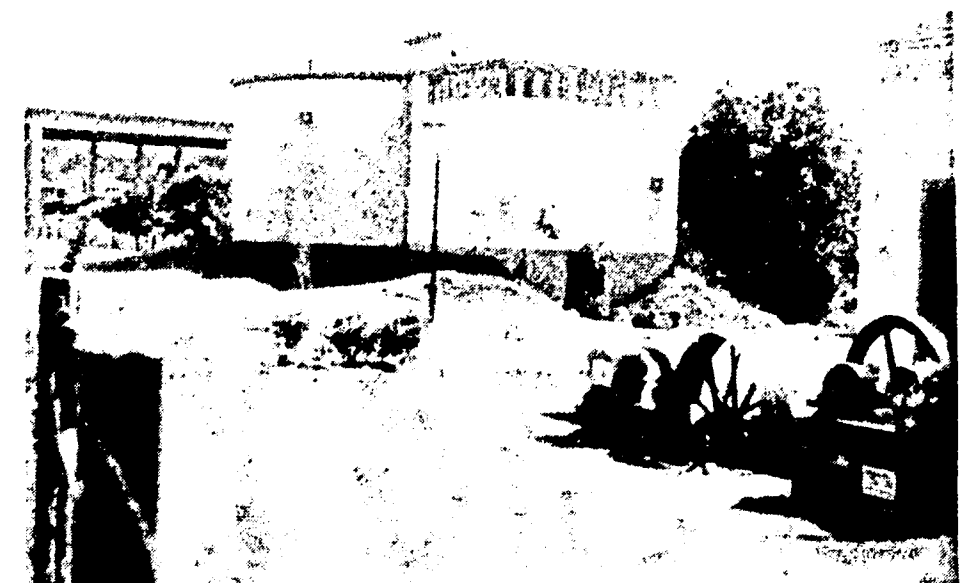
Diese Pumpanlage, die als Erinnerungstück aufgestellt ist, versorgte viele Jahre den Wasserbehälter am Steinberg mit dem lebensnotwendigen Naß.
