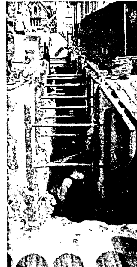
Die Erdarbeiten in der Feldstraße gehen zügig voran.
