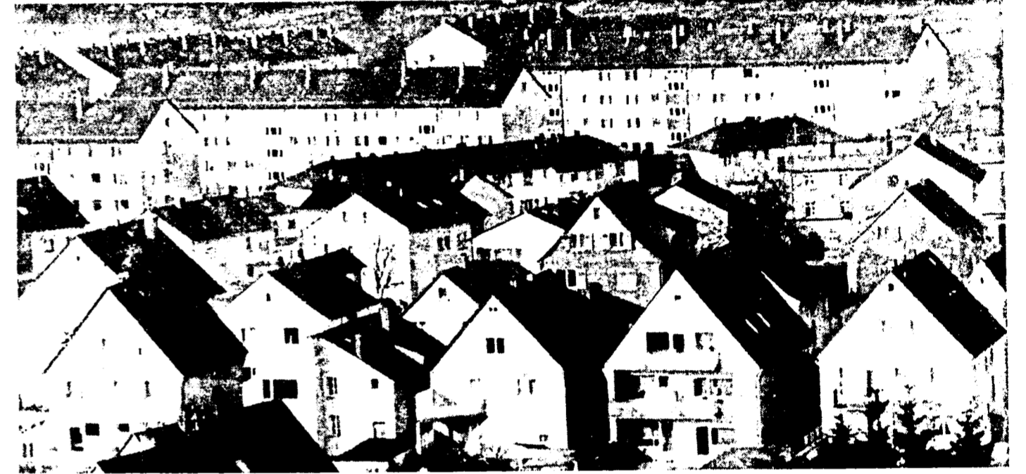
Aus der Vogelperspektive: Blick zu den Wohnblöcken an Leukertsweg und Südlicher Ringstraße.
