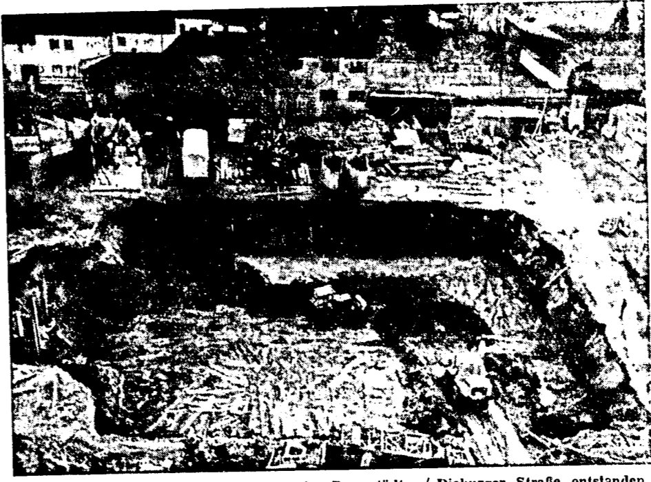
Diese riesige Baustelle ist jetzt an der Ecke Darmstädter / Dieburger Straße entstanden. Geweiht sind ihr das ehemalige Luftschutzhau in der Dieburger Straße, die alte Apotheke Mülich und noch eine Reihe anderer Gebäude in der Darmstädter Straße.
