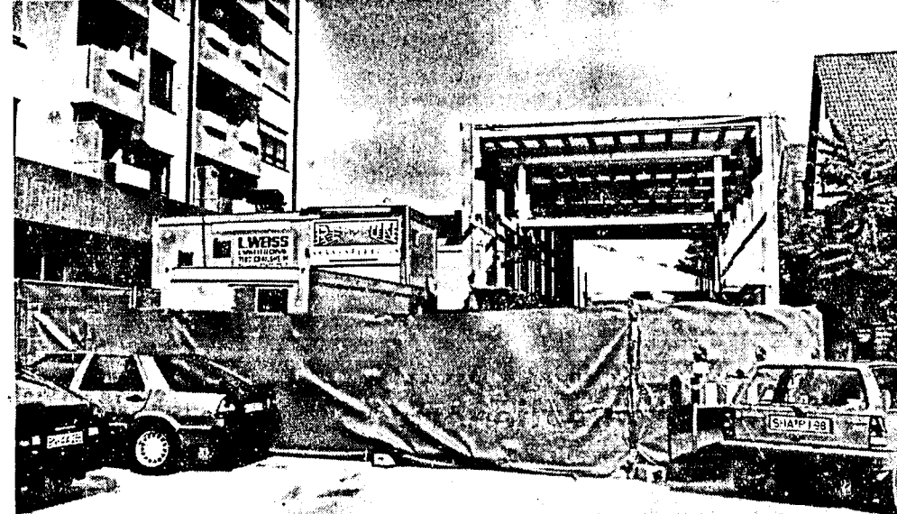
Eine Plastikfolienwand versperrt den Blick auf das Sanierungsgebiet, das von einem mächtigen Zeltbau beherrscht wird. In ihm wird die belastete Erde in Fässer gefüllt.
