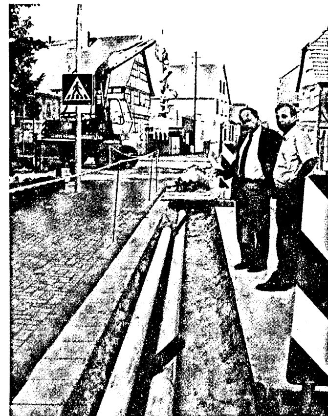
Ein Bild vom zügigen Fortgang der Bauarbeiten zur Erneuerung der Gasversorgungsleitungen in der Egelsbacher Schulstraße...
