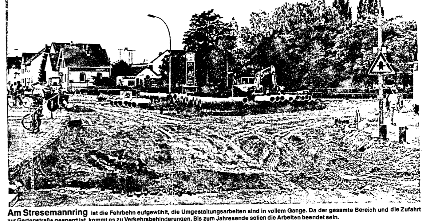
Am Stresemannring ist die Fahrbahn aufgewühlt, die Umgestaltungsarbeiten sind in vollem Gange. Da der gesamte Bereich und die Zufahrt zur Gartenstraße gesperrt ist, kommt es zu Verkehrsbehinderungen.
