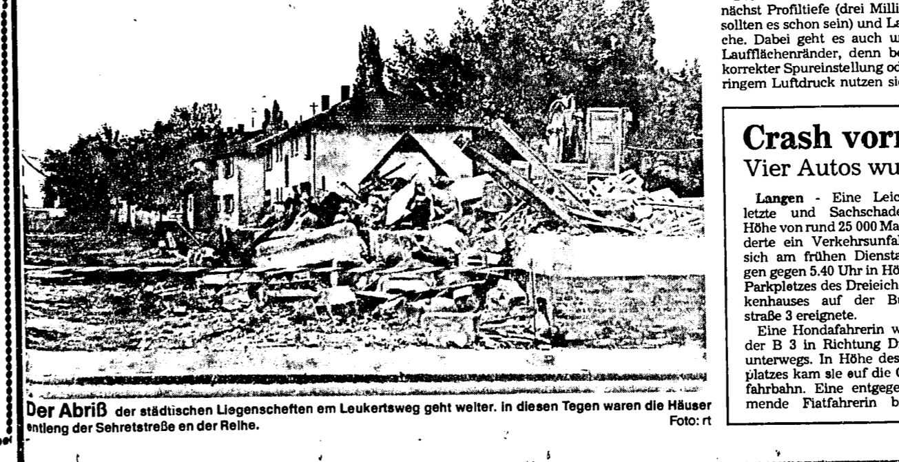
Der Abriss der städtischen Liegenschaften am Leukertsweg geht weiter. In diesen Tagen waren die Häuser entlang der Seherstraße an der Reihe.
