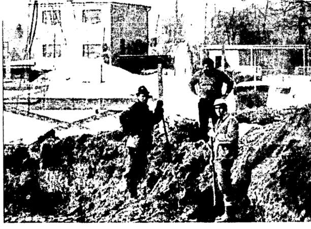
Für die Spezialanlage im Schwimmstadion wurde eine Baugrube ausgehoben, die bis auf sechs Meter vertieft werden muß.
