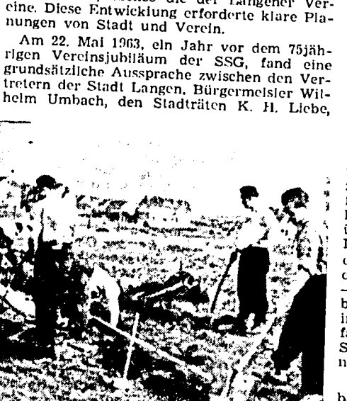
Die Platten für die Laufbahneinfassung werden verlegt. Alle Platten waren selbst in Formen gefertigt.
