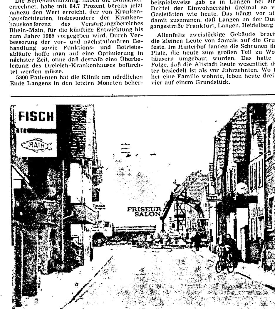
Ein Bild wie zur Zeit des Sonntagsfahrverbots: kein einziges Auto in der Wassergasse, in der man sonst kaum einen Parkplatz findet. Viele meinen, sie sei durch die Baustelle nicht passierbar. (Siehe auch Bericht auf Seite 4)
