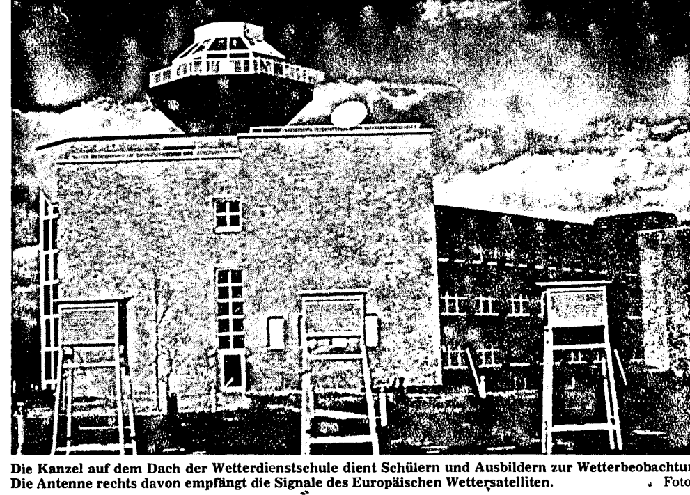
Die Kanzel auf dem Dach der Wetterdienstschule dient Schülern und Ausbildern zur Wetterbeobachtung. Die Antenne rechts davon empfängt die Signale des Europäischen Wettersatelliten.
