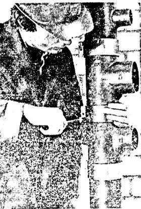
Ein Beitrag zum rationellen Lernen: Das moderne Gubrohr für Abblühtungen hat keine Muffen mehr, die mit Handstrik und Bleivergäß miteinander verbunden werden. Die Verbindung erfolgt mit rostfreien Chromstahl-Manschetten und kochendwasserbeständigen Gummidichtungen; eine einfache und saubere Sache.
