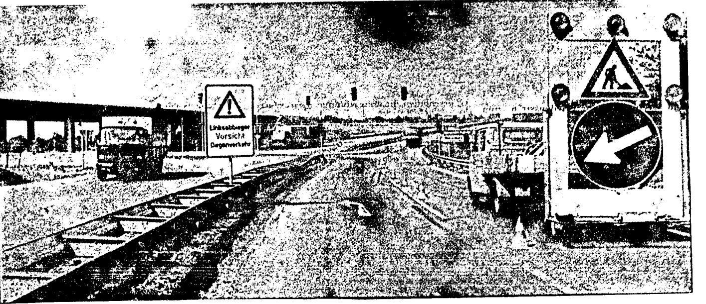
Eine der unfallträchtigsten Stellen unserer Stadt wird jetzt besser gesichert: die Einmündung der B 486 zur Nordumgebung an der Mühlstraße. Vom Heissenchen Straßenzug wird eine Lichtzeichenanlage installiert, die mit rotem und grünem Licht den Verkehr regeln soll. Besonders die aus Offenbach kommenden Linksabbieger haben trotz weithin sichtbarer Schilder immer wieder zu Unfällen beigetragen. Das soll anders werden. Die Ampeln selbst stehen bereits. Nun wird es nicht mehr lange dauern, bis grünes Licht den Verkehr fließen läßt und rote Unfälle vermehrt.
