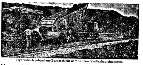
Hydraulisch gebundene Bergschicht wird für den Straßenbau eingesetzt.
