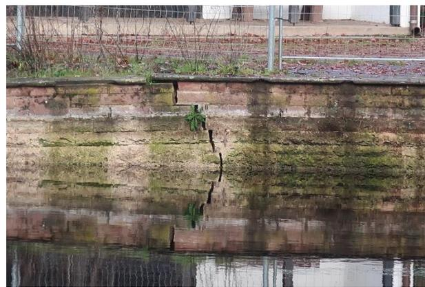
Abbildung 14: Ausbrüche, Wurzeleinwuchs Westufer
