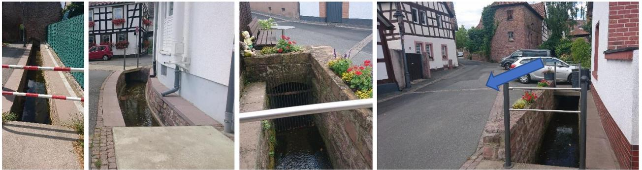
Abbildung 19: eingegengtes Gewässer, Zuläufe Dachentwässerung    Abbildung 20: Borngasse, Ausuferungen
