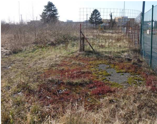
Abbildung 48: Überwachsene kleinere Asphaltfläche an der Moselstraße
